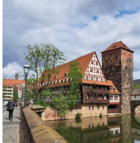
Historischer Bestand Beispiel Nürnberg: Das Studentenwohnheim Weinstadel/Wasserturm in der Altstadt von Nürnberg hat 73 möblierte Einzelzimmer mit Gemeinschaftsduschen und -bädern. © V. Bode / IfL
