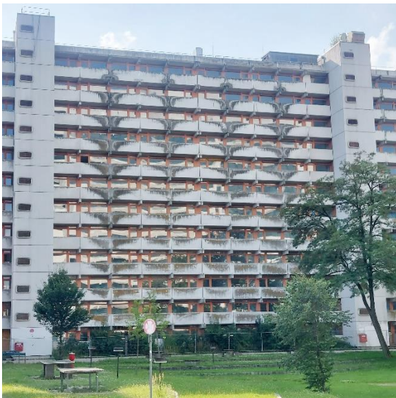
Sanierungsstau Beispiel München: Das leerstehende Haus 12 in Deutschlands größter Wohnanlage eines Studierendenwerks. In der Studentenstadt Freimann stehen derzeit sanierungsbedingt mehr als 1000 Appartements der insgesamt etwa 2.400 Wohnplätze umfassenden Anlage nicht zur Verfügung.
